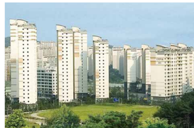
용인신봉 동일하이빌아파트 현장
